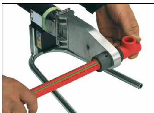
Uppvärmning av rör och rördel.
