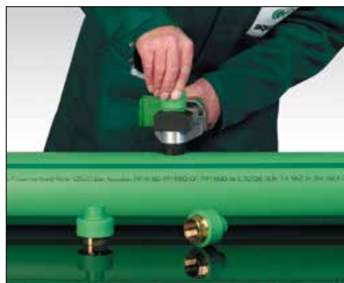
Uppvärmning av det element som skall svetsas
