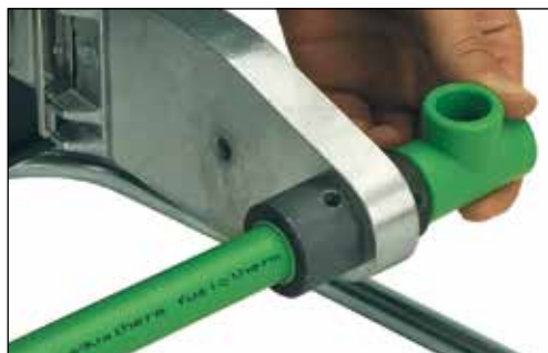
Upphettning av rör och rördel
