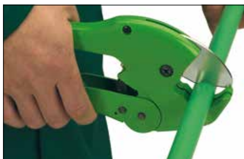
Avklippning av röret
