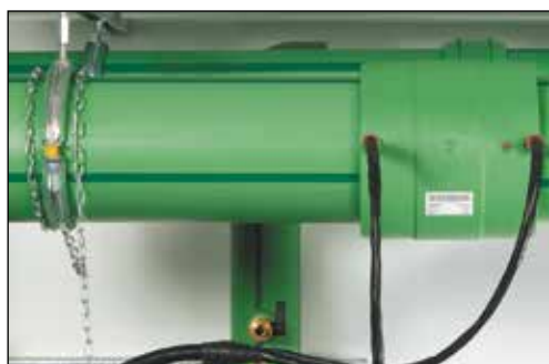
Ställ in dimensionen på svetsmaskinen. Starta och övervaka svetsprocessen. Håll avkylningstiderna. Klart!
