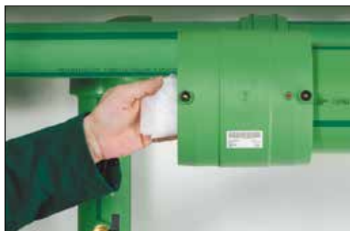
Rengör elektrossvetsmuffen igen med rengöringsduken
