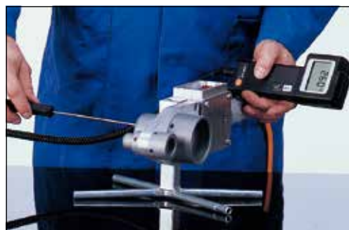
Temperaturkontroll med ytmätningssinstrument
