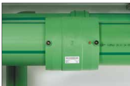
Skjut in det andra skalade och rengjorda röret i muffen
