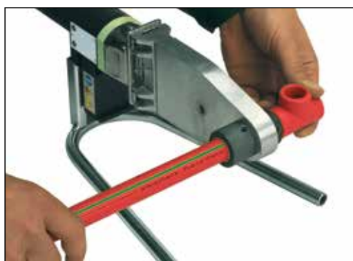
Uppvärmning av rör och rördel.
