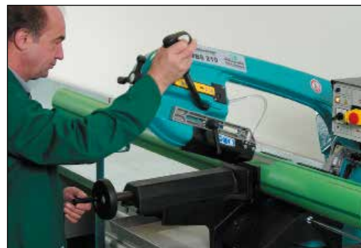
Kapp 160 mm røret i riktig lengde før sveising.
