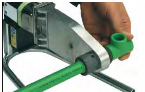
Oppvarming av rør og rørdel
