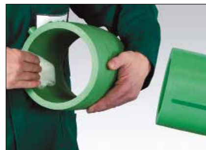
Rengjør el-sveisemuffens innside
