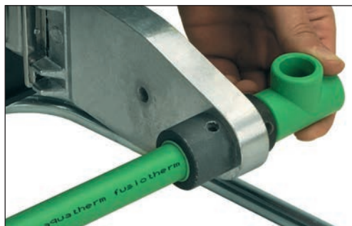
Upphettning av rör och rördel
