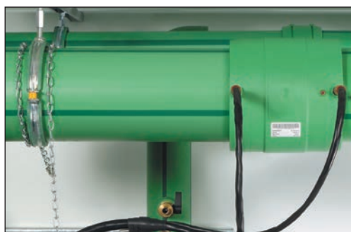
Ställ in dimensionen på svetsmaskinen. Starta och övervaka svetsprocessen. Håll avkylningstiderna. Klart!
