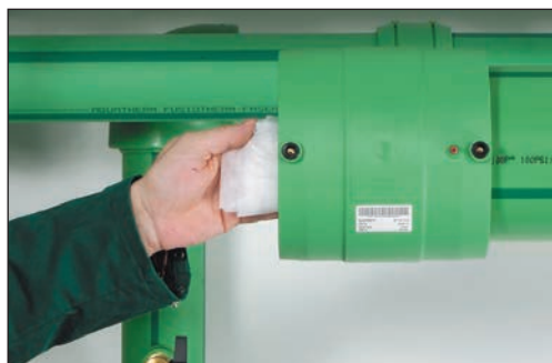
Rengör elektrossvetsmuffen igen med rengöringsduken
